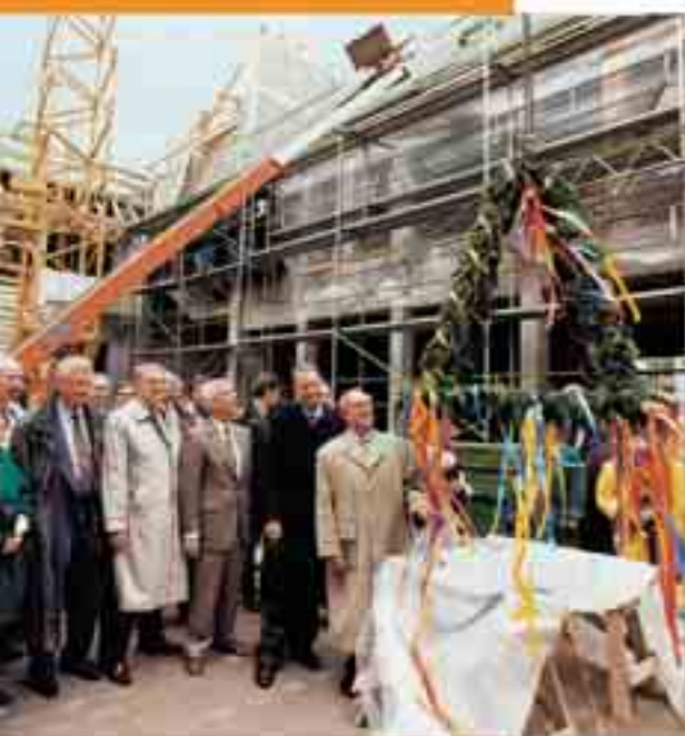
Richtfest 1997: Im November desselben Jahres konnte bereits der neue Anbau an das IHK-Gebäude eingeweiht werden.
